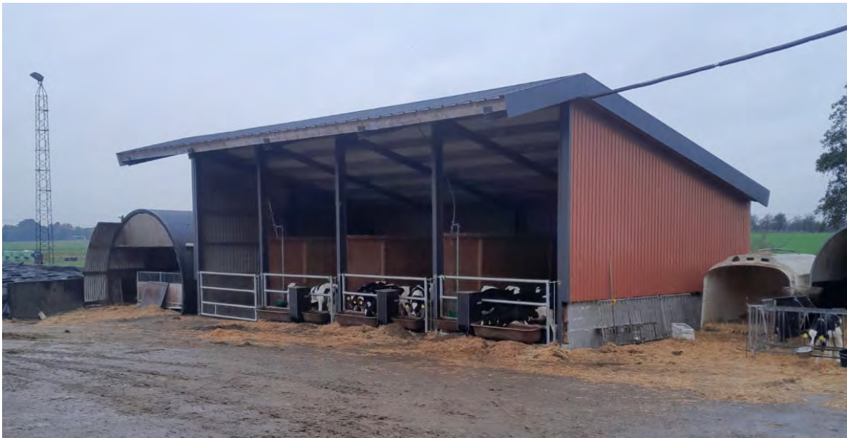
Figur 2. Ny kalvestald på udvidet kalveplads, der søges lovliggjort. Ny goldkostald opføres i samme byggestil.
