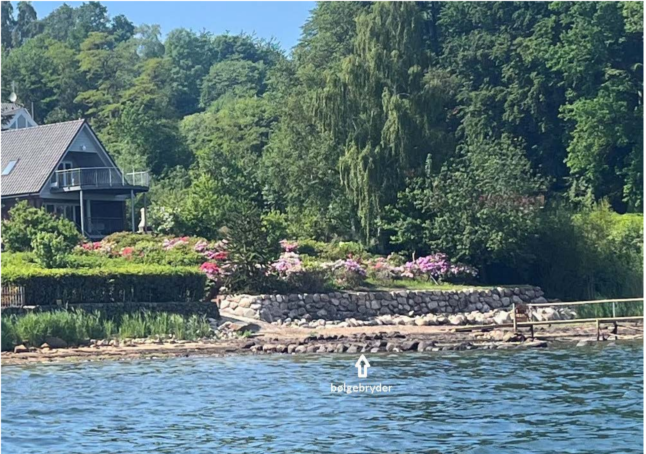
Figur 4: Den genopbyggede mur (billede fra maj 2024) har et ensartet udtryk med den sydlige naboejendom. Yderligere passiv kystbeskyttelse i form af bølgebrydere af sten ses i forgrunden samt på matrikelkortet på side 3. De oprindelige sten blev også genanvendt.
