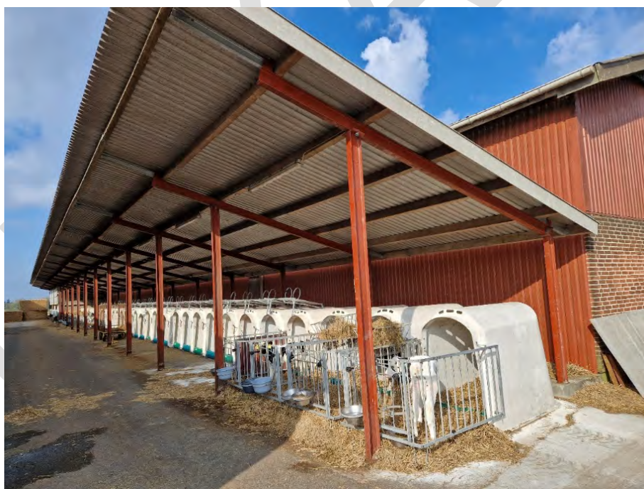
Figur 2. Den nye kalvestald.
