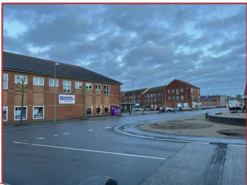
7 Hærvejen 24 set fra banken på Østergade. Taget fra sydsiden af fortov på Østergade.
