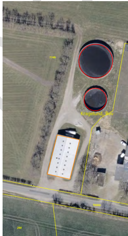
Figur 2: Oversigt over gyllebeholdere og maskinhus på Skyttehusvej 12A, 6330 Padborg
