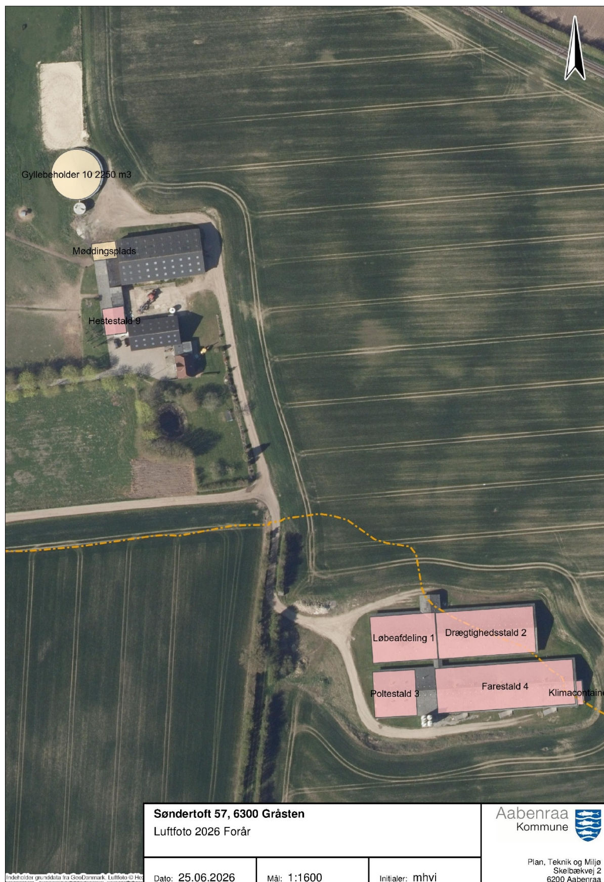
Figur 1. Oversigt over stalde og gødningsopbevaringsanlæg.
