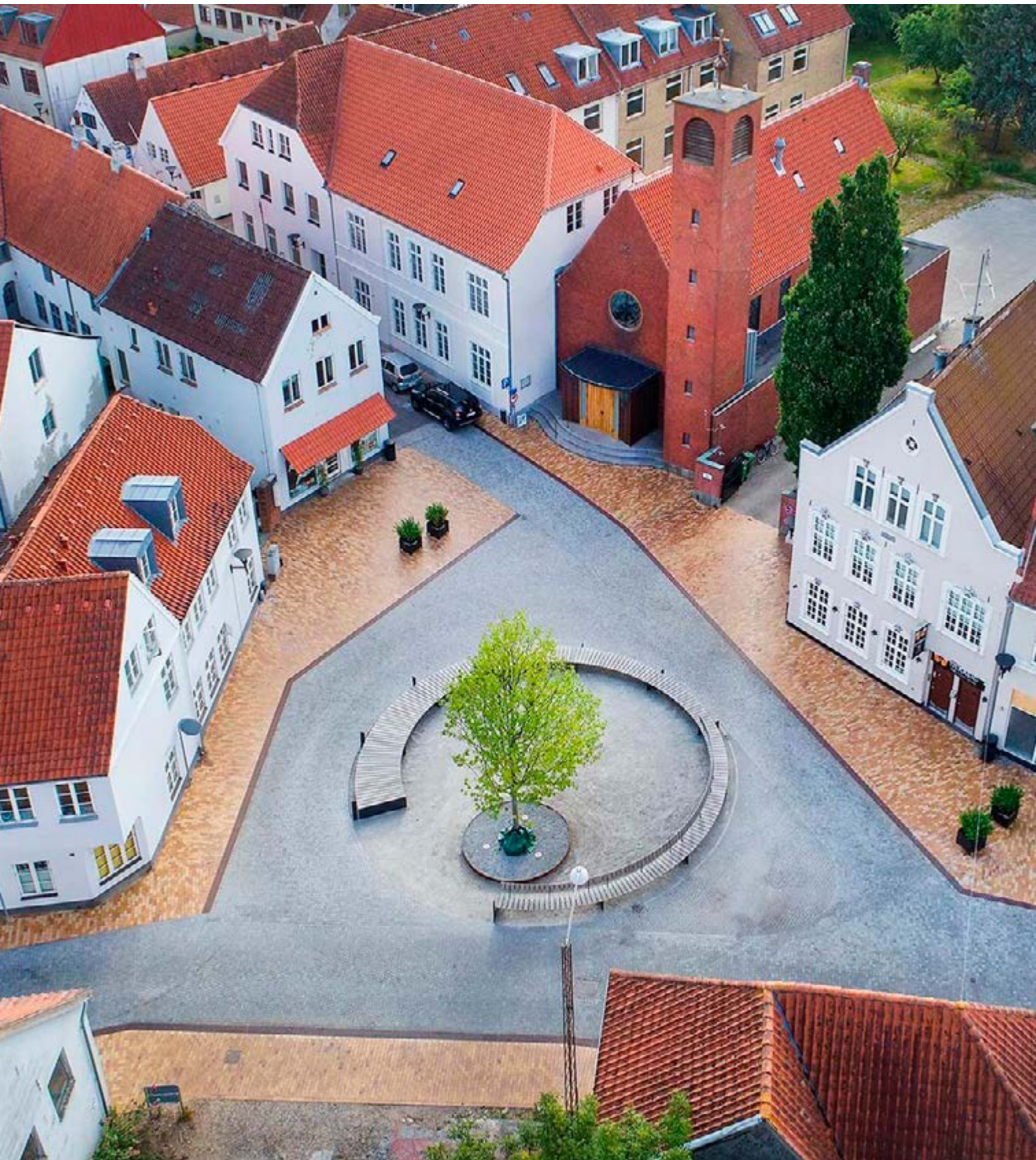
Som en del af i et større byfornyelsesprojekt er Søndertorv blevet belagt med den ikoniske gule teglstensbelægning, som kendetegner gaderne i den historiske bymidte.
