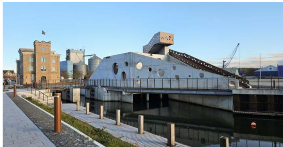
Ø.tv: Industribygninger og lagerfaciliteter Ø.th: Mølleåen, mindre jollehavn N: Pumpehuset, Stenbjerghus og Gammelhavn i baggrunden
