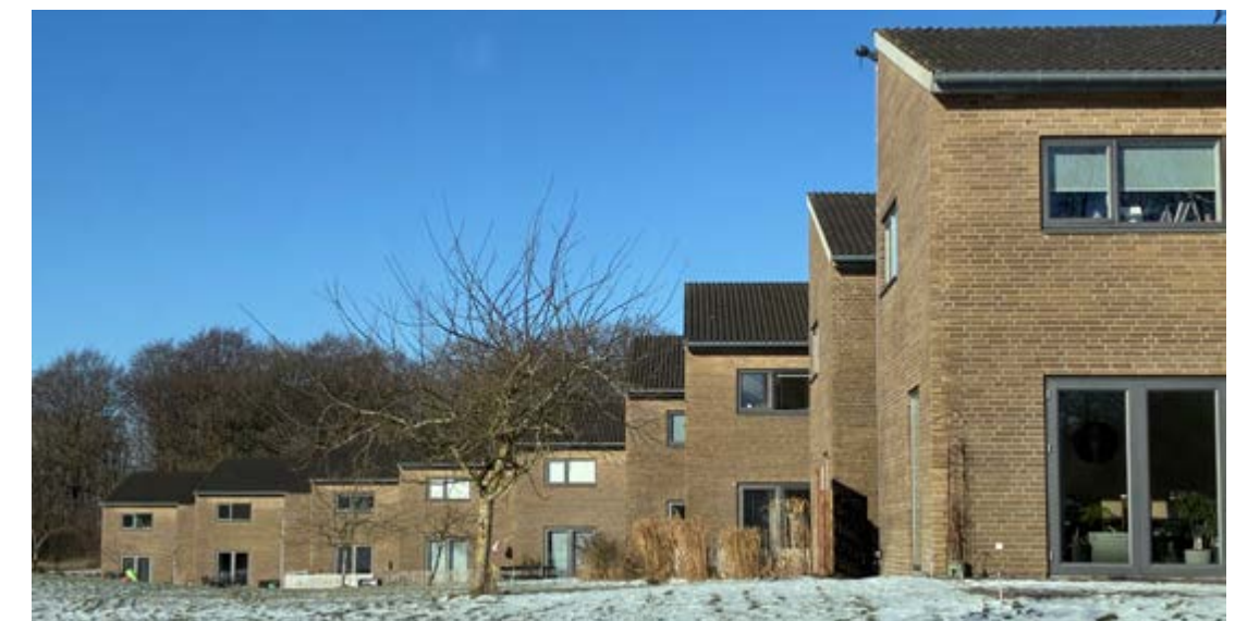
Ø.: Etageboligerne i to etager med deres fremtrukne facadepartier. N.: Det rytmiske forløb af gavle, som den slyngede struktur skaber.
