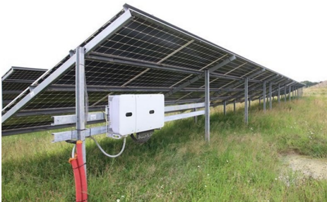
Foto: Eksempel på inverter
