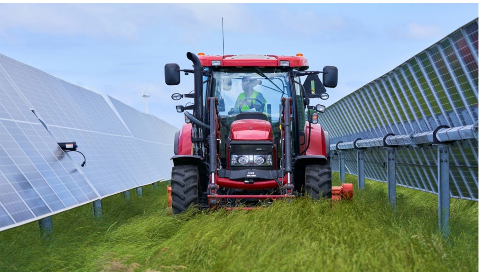
Foto: Eksempel på solceller på trackerstativer.
