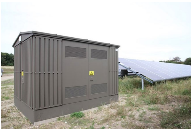
Foto: Eksempel på teknikbygning
