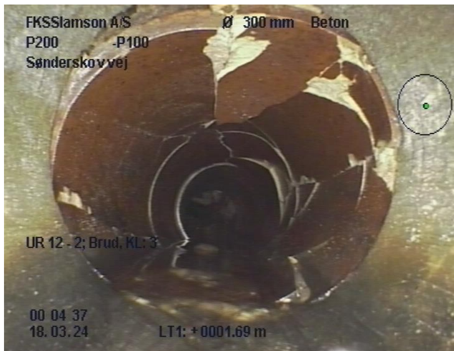
Figur 6: Udført TV-inspektion. Station 01.69 m fra udløb
