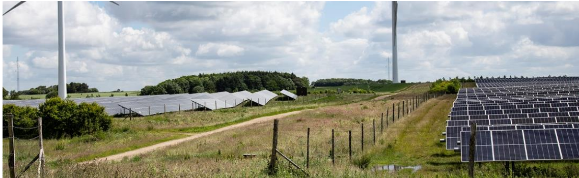
Til venstre ses solpaneler på faste stativer og til højre ses solpaneler på trackersystem. Fotoet illustrerer ligeledes farveforskellen på solpanelerne afhængig af hvordan lyset falder på dem.
