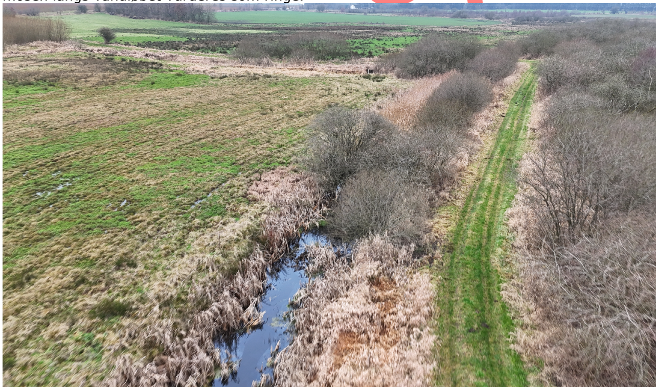
Figur 5: Tilsyn af Kanal 56 december 2025. Billedet er taget ved vandløbets station 1.150 mod Randkanal SW.
