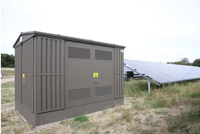
Foto: Eksempel på teknikbygning.
