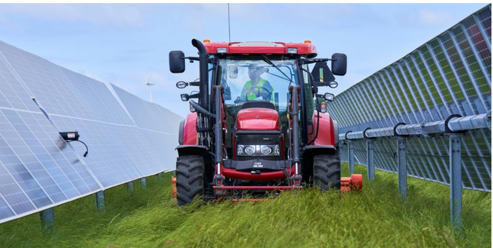
Foto: Eksempel på solceller på trackerstativer.
