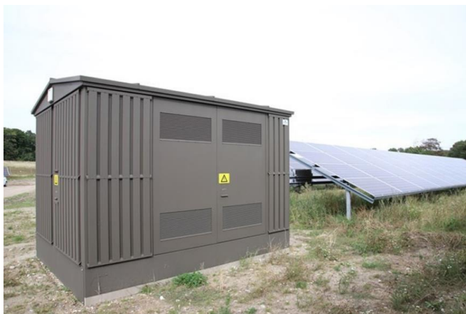
Foto: Eksempel på teknikbygning
