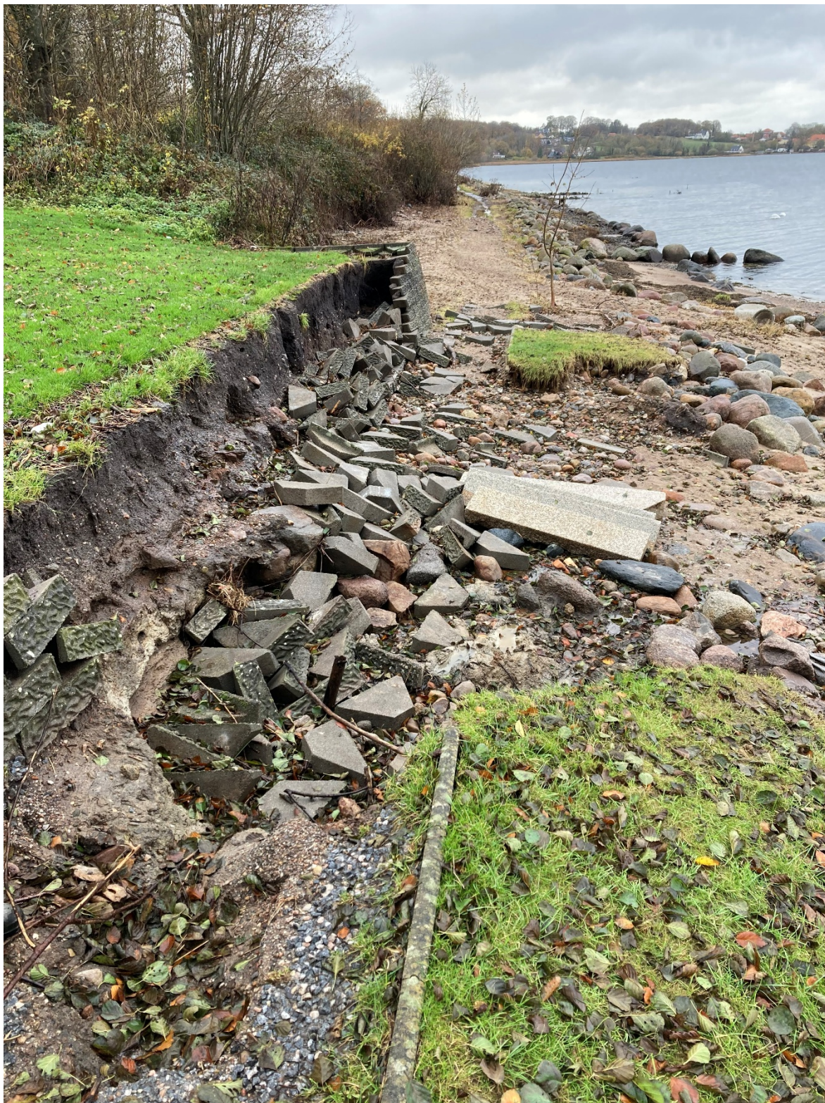
Figur 3: Foto af den nordligste del af projektstrækningen som det så ud umiddelbart efter stormfloden i oktober 2023
