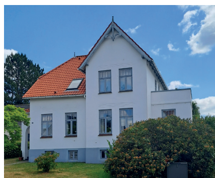
Gamle Kongevej 16 - kat. 3 Opført: 1912, træk fra schweizerstil
