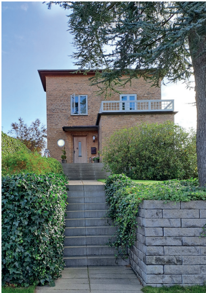
Gamle Kongevej 60 - Funkis villa med rent kubistisk formsprog. Funktionalistiske træk, som halvtage over hoveddør, det runde vindue og vinduer uden sprosser.
