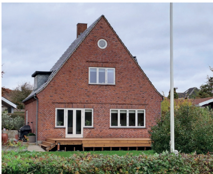
Stentoftvej 11 - Funktionalistisk villa med markante vinduesbånd, vinduer uden opsprossning og enkle mursten-detajler.
