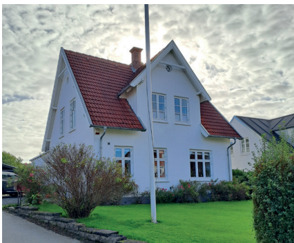
Gamle Kongevej 52 - kat. 4 Opført: 1912 - træk fra schweizerstil
