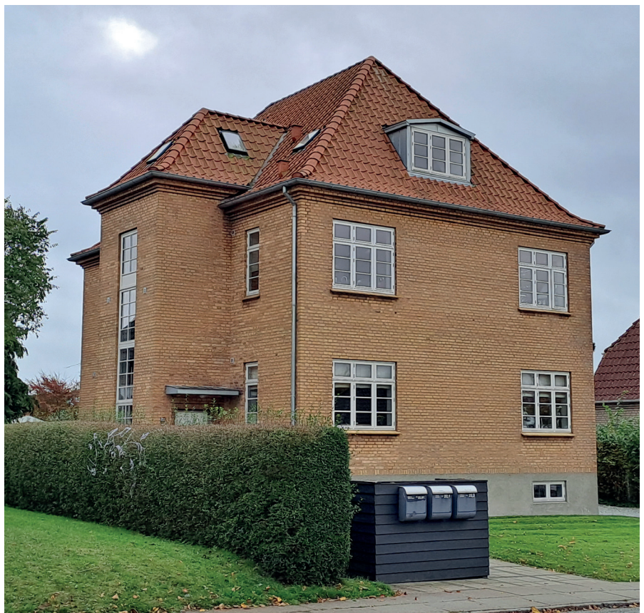
Gamle Kongevej 22 - Funktionalistisk etageejendom med træk fra den regionale funktionalisme i form af det stor teglhængte tag med opsalkning og ikke mindst de opsprossede vinduer. Trappeopgangen er markeret i facaden i form af et fremtrukket parti, med et højt vertikalt vindue på tværs af etagerne.
