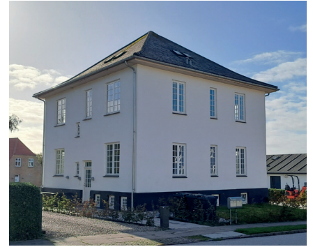
Gamle Kongevej 38 - kat. 4 Opført: 1912
