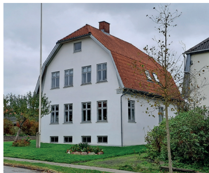
Knapløkke 2 - kat. 4 Opført: 1921
