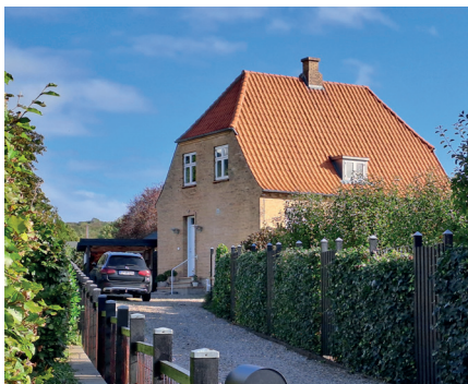
Knapløkke 5 - kat. 4 Opført: 1932
