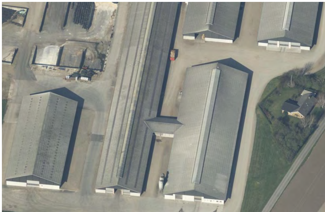
Figur 5: Materialer og farver på de eksisterende bygninger, kilde: skraafoto.dataforsyningen.dk
