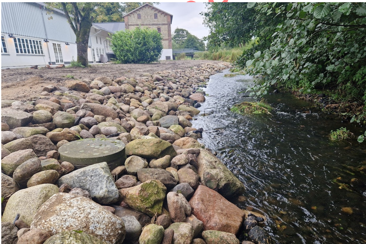
Figur 3: Strækningen som den ser ud efter brinksikring. Regnvandsbrønden ses i billedets venstre side.
