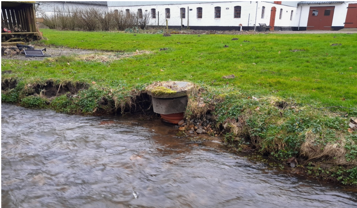
Figur 2: Foto af regnvandsbrønd inden etablering af brinksikring.
