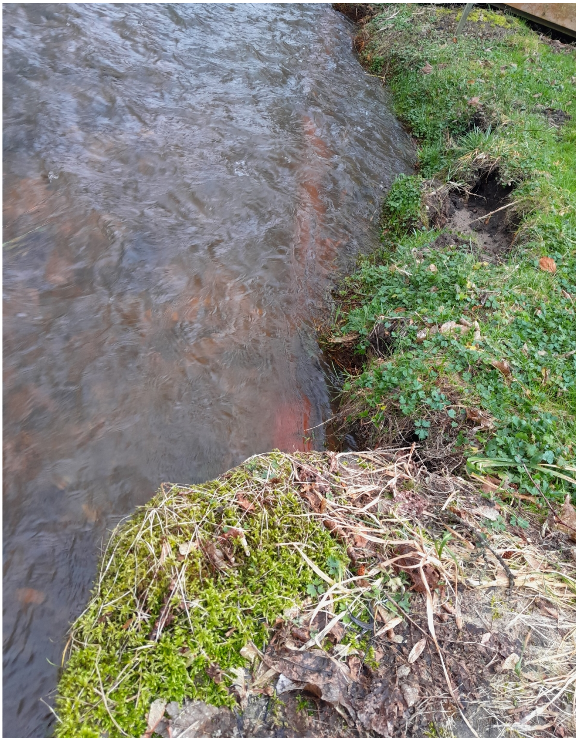
Figur 1: Foto af blotlagt regnvandsledning (orange pvc rør) inden etablering af brinksikring.
