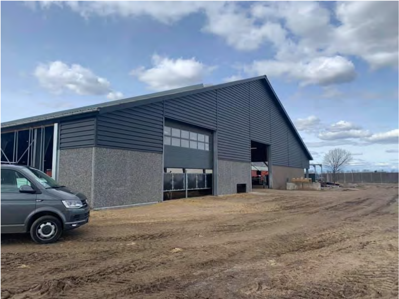
Figur 8. Ved renovering og nybyggeri vælges grå søstenselementer og antracitgrå plader. Foto: Klaus Jakobsen
