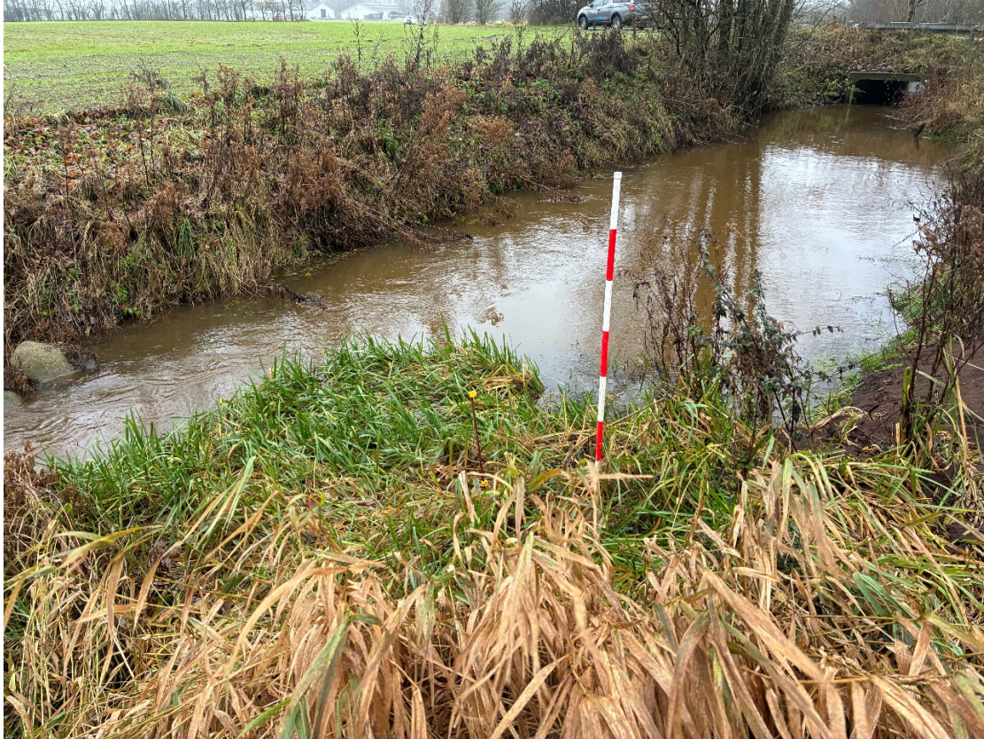
Figur 3: Eksisterende sandfang. Gul markering viser udløb fra minirenselanlæg.
