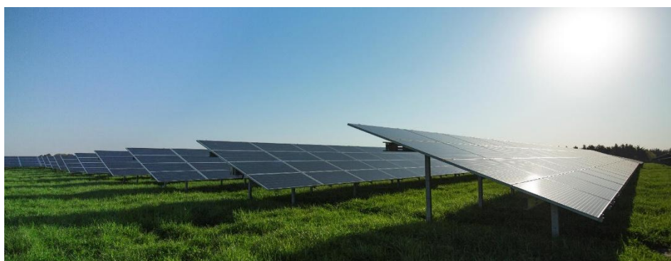
Figur 6-6 Eksempel på solcellepaneler på faste stativer med matgrå overflade på græsarealer.
