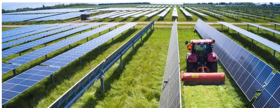
Figur 6-7 Foto af solcellepaneler på bevægelige stativer (trackere). Her er enkelte af rækkerne vendt i en position så tæt på lodret som muligt, for at gøre plads til slåning af græs imellem rækkerne.
