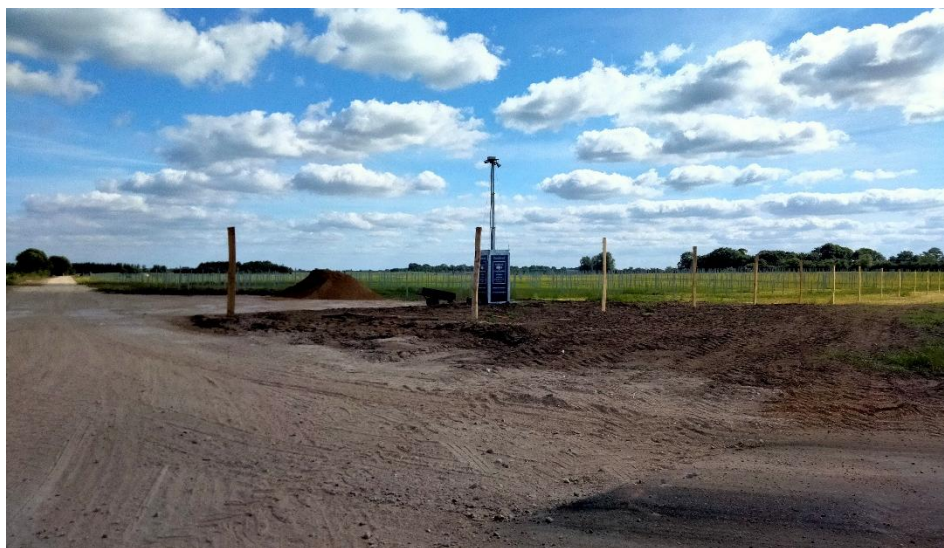
Figur 8-8 Referencefoto af jordarbejder til en intern vej og arbejdsareal med oplag.
