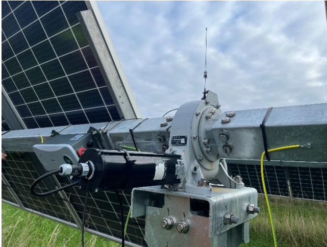
Trackerens motor set fra bagsiden og mellem panelerne.
