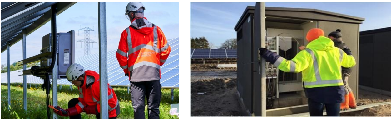
Figur 6-17 Fotos af anlægsaktiviteter ved opsætning af anlæg (Foto: European Energy).
