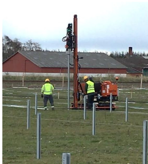
Figur 8-6 Referencefoto af den maskine, som anvendes til nedvibrering af solcellepanelernes stativer.
