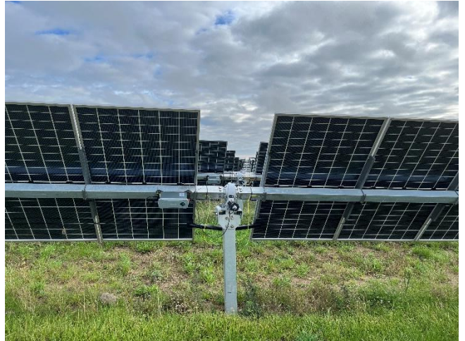
Solcellepaneler monteret med trackere set på tværs af rækkerne.
