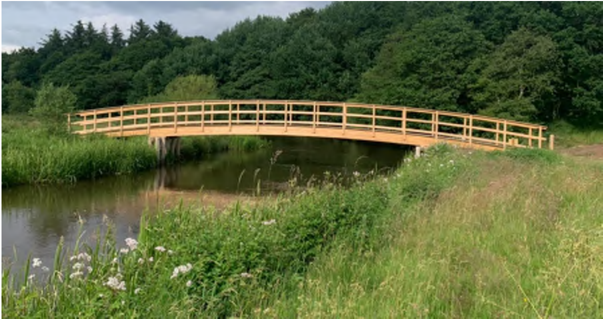
Figur 30 26 m lang gangbro fra Anneberg Limtræ, etableret i Varde Å.
