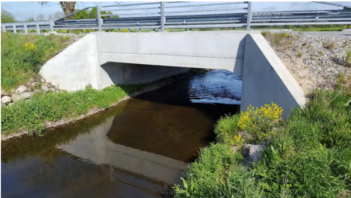
Figur 25 Betonelementtunnel fra Perstrup ved Kastbjerg Å, etableret i 2016.
