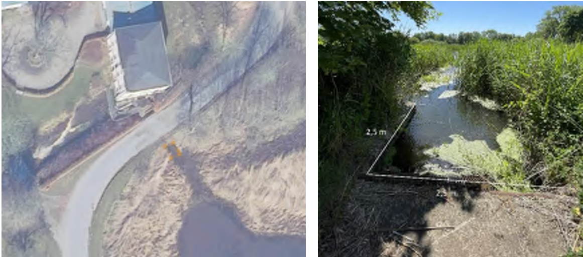
Figur 28 Indløb til turbinekanal
