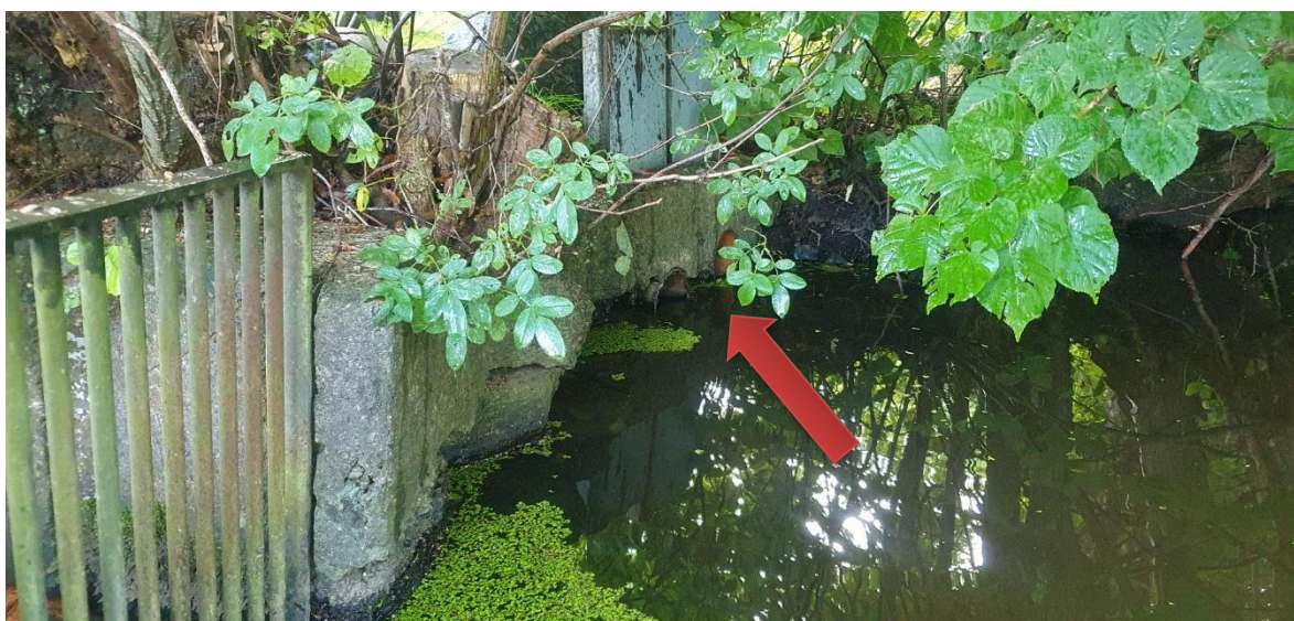
Figur 17 2 stk. \varnothing 160 rør ved afløb fra sø afproppes.
