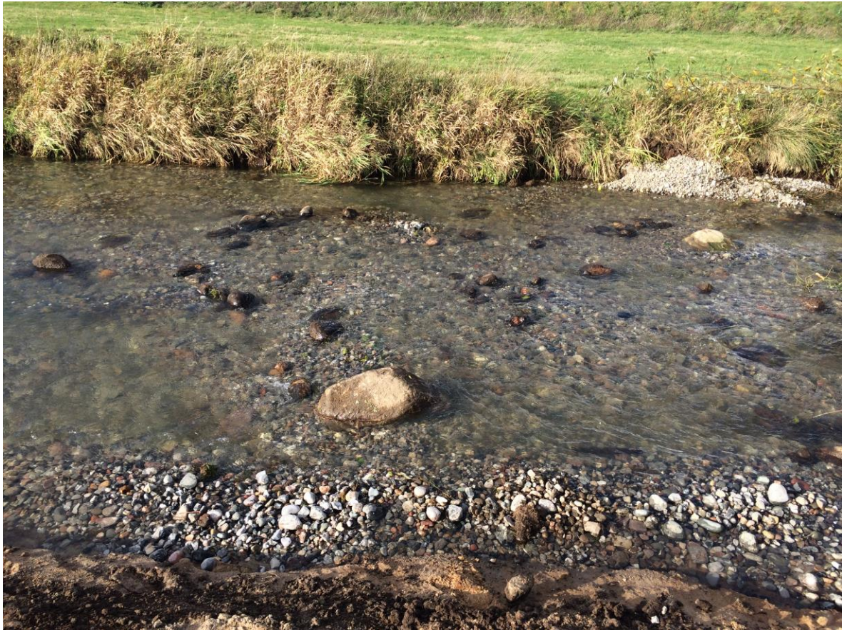
Figur 29 Eksempel på hvordan udlægning af skjulesten (stentype III) udlægges varieret.
