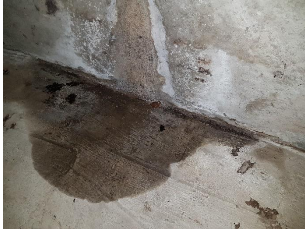
Figur 13 Opfugtet område i kælder.
