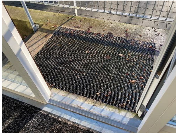
Figur 10 Skraberist uden afløb ved bygning 4, indgang mod syd.
