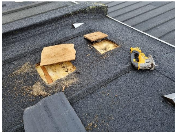
Figur 6 Tag afsnit 7 skrå tagflade, TI prøver P3 og P4. Kraftig skimmel på underside af krydsfinér i prøve P3 og P4.
