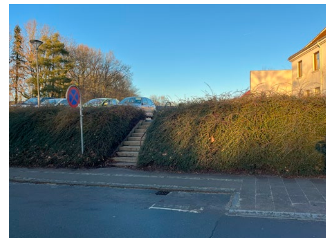
En ny mere synlig trappe på Vestergade skal binde bymidtens funktioner bedre sammen blandt andet med stationens område. Foto fra 12.01.2025.
