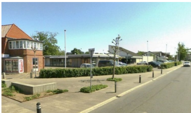
Hjørnet af Hærvejen/Østergade 15.05.2018 før nedrivning af det tidligere Røde Kro Center.
