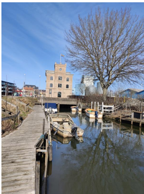
Figur 3.4: Mølleåens udløb i Aabenraa Fjord. Her planlægges anlagt en pumpe og en sluse, således stormfloder ikke trænger ind i Mølleåen og Mølleåen kan komme af med vandet under stormfloder.
