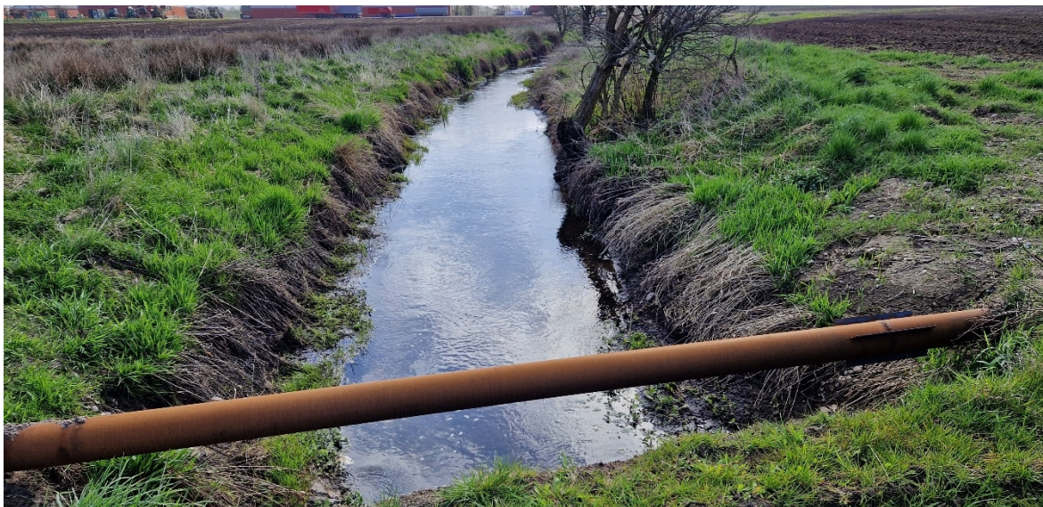
Figur 2: Ledningen der krydser vandløbet er etableret umiddelbart opstrøms overkørslen i station 14.572 meter
