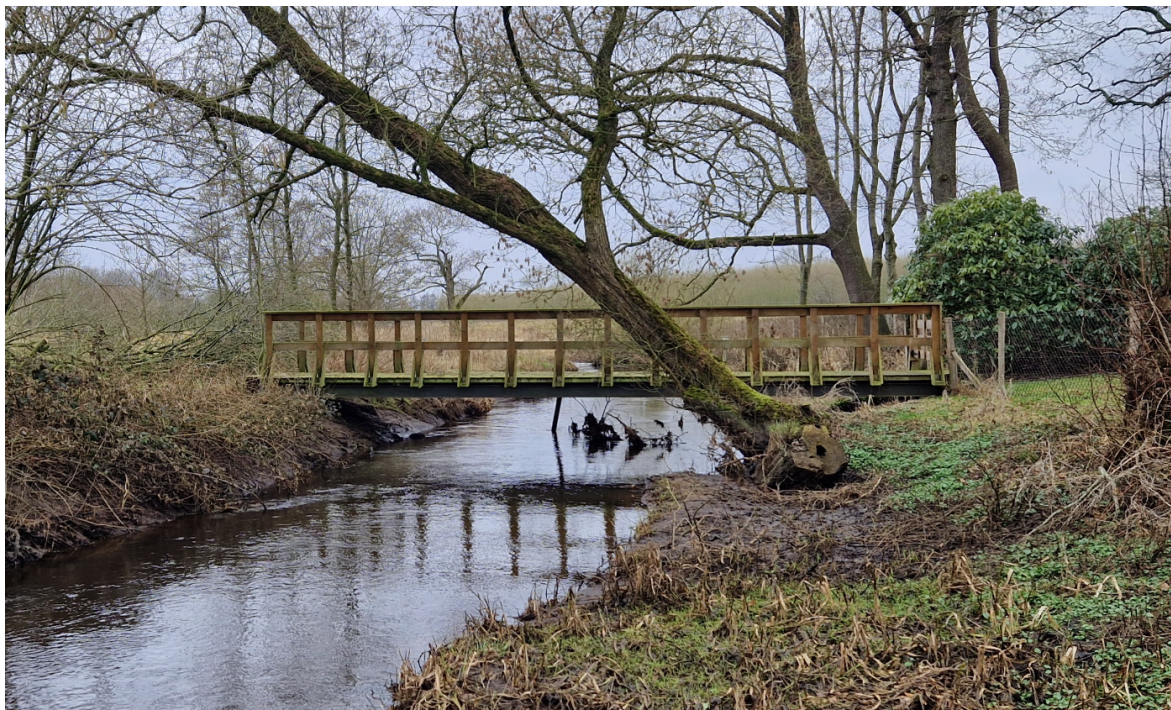
Figur 2: Som det ses af dette billede, er broen etableret, så hele vandløbsprofilen går ubrudt igennem
