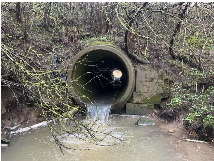
Figur 4: Forskydning ved indløb (1. rørelement fra øst). Rørelement og frontmur fjernes.
