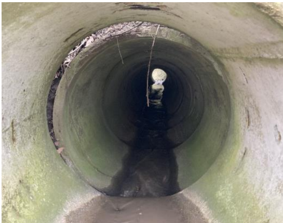
Figur 4: Forskydning ved indløb (1. rørelement fra øst). Rørelement og frontmur fjernes.
