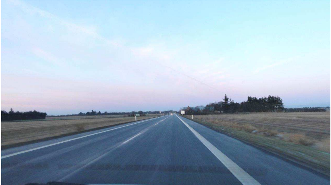
Figur 7. Eksempel på indsnævring ved hjælp af afmærkning.
