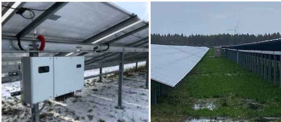
Figur 4-3: Invertere placeres under solpanelerne. Transformere placeres spredt i området og skjules under solenergi-panelerne. Foto: Better Energy.
