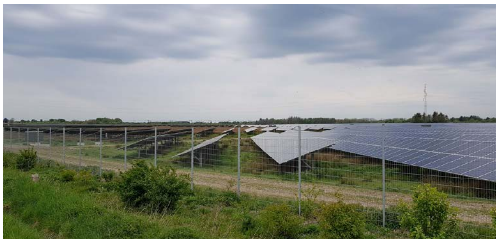
Figur 3-31: Solenergianlæg ved Åbenråvej. Foto: COWI
